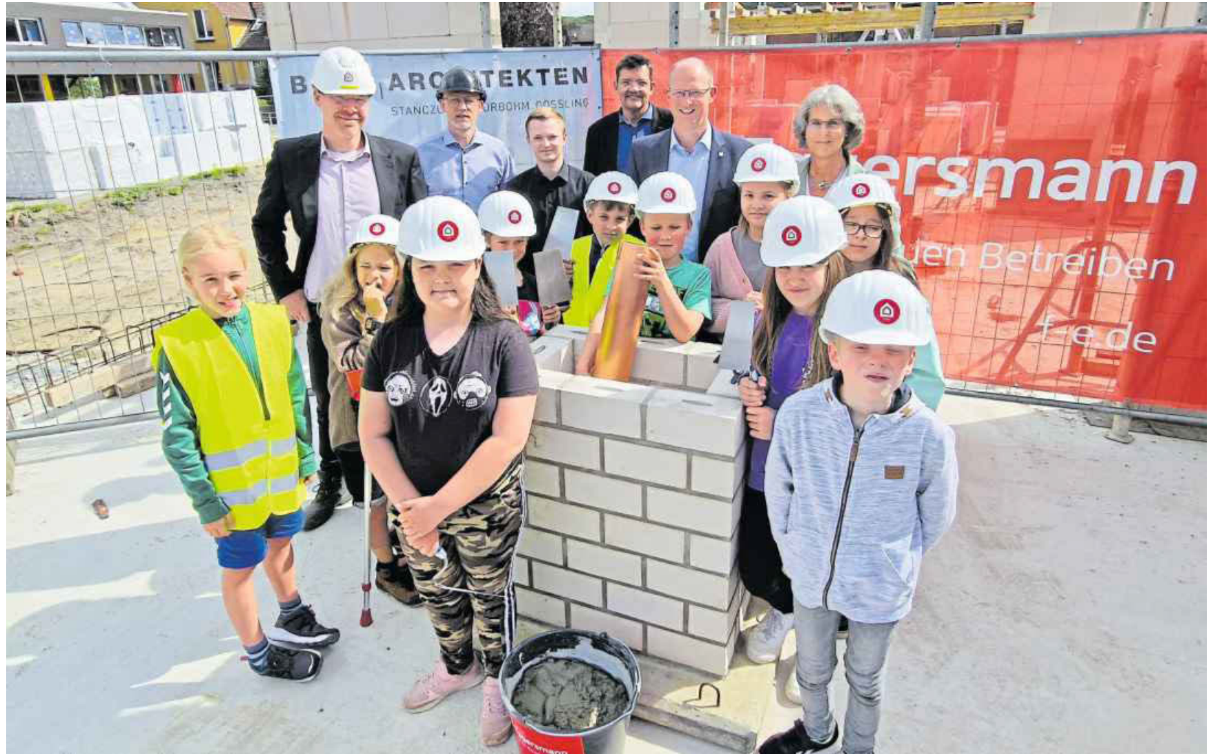
Gartnischer Grundschüler veranstalten gemeinsam mit Marc-André Zander (Bauunternehmen Eggersmann, hinten, von links), Mario Schurbohm, Philipp Harazim, Dirk Stanczus (alle BKS), Bürgermeister Thomas Tappe und Schulleiterin Kristina Niemeyer die Grundsteinlegung für den Neubau. Fotos: Uwe Pollmeier
